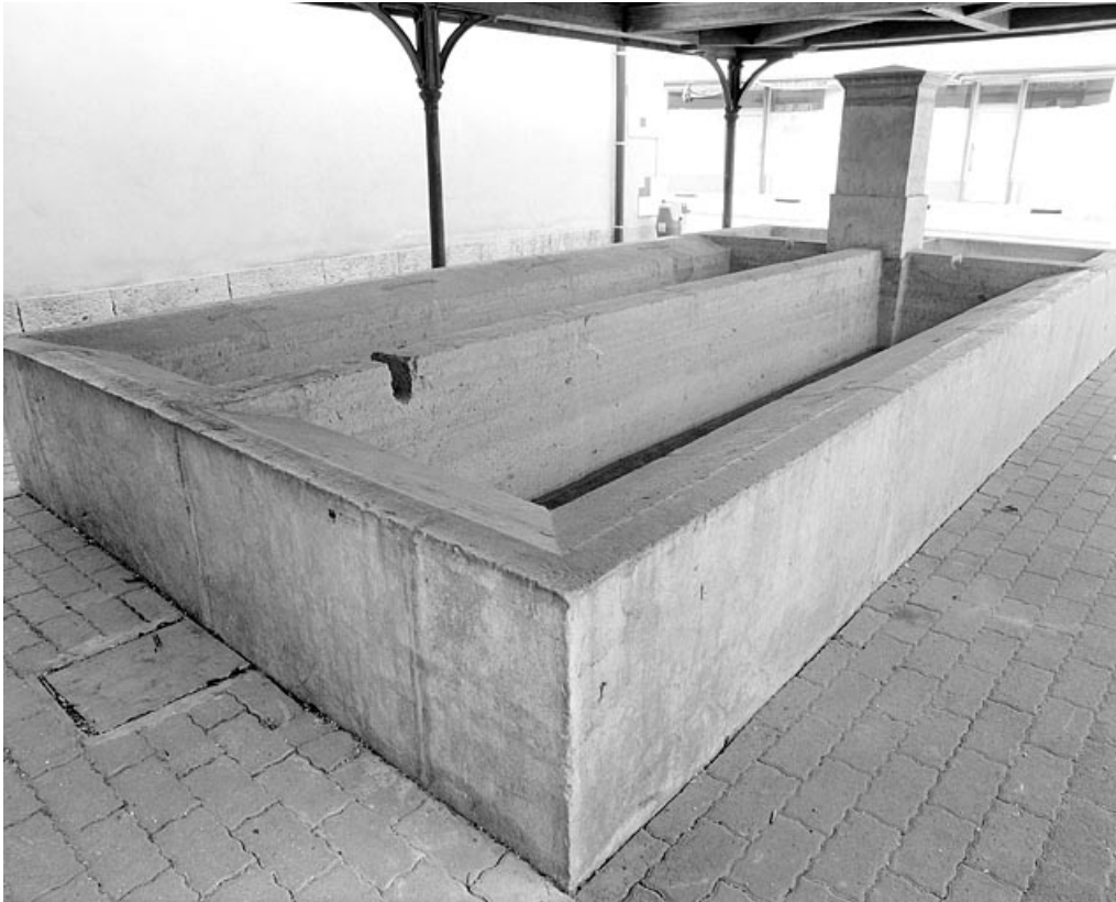
Bassin côté lavoir, vu de trois quarts.
