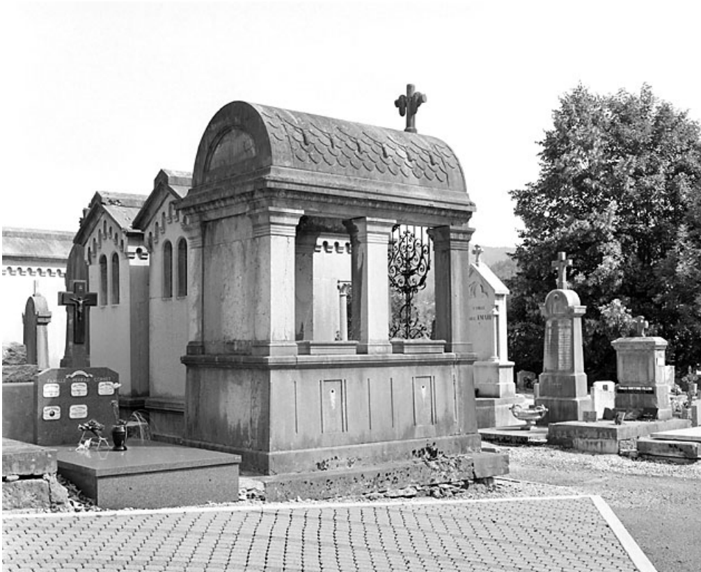
Façades postérieure et latérale gauche.
