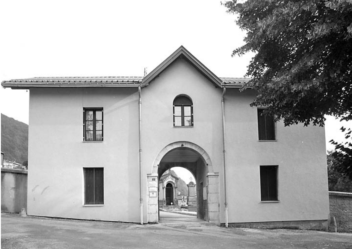
Pavillon d'entrée (conciergerie et logement).
