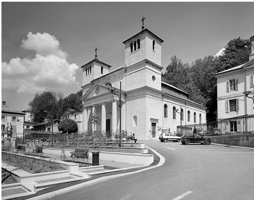
Vue d'ensemble rapprochée, côté est : église.
