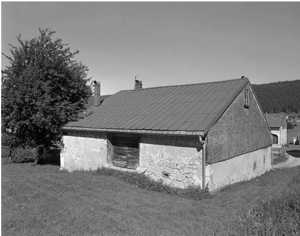
Façade postérieure et face latérale gauche.
