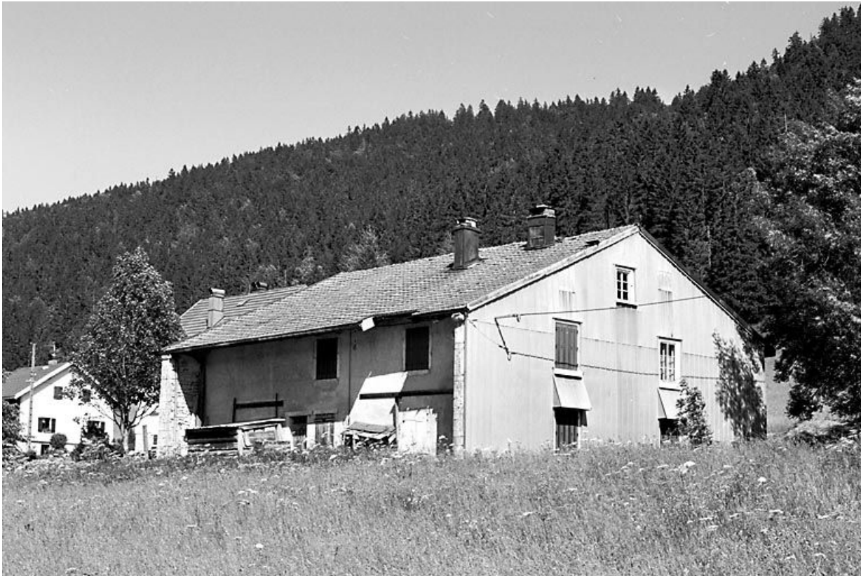
Façade antérieure et face droite.
