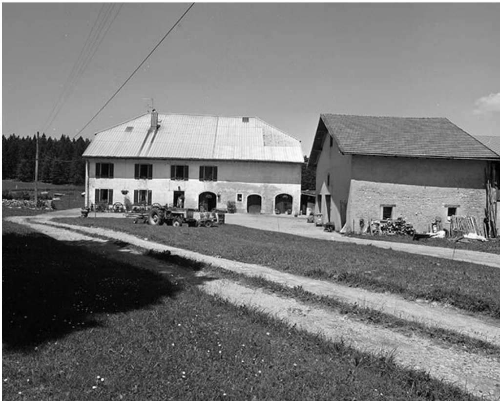
Vue éloignée de la façade antérieure.
