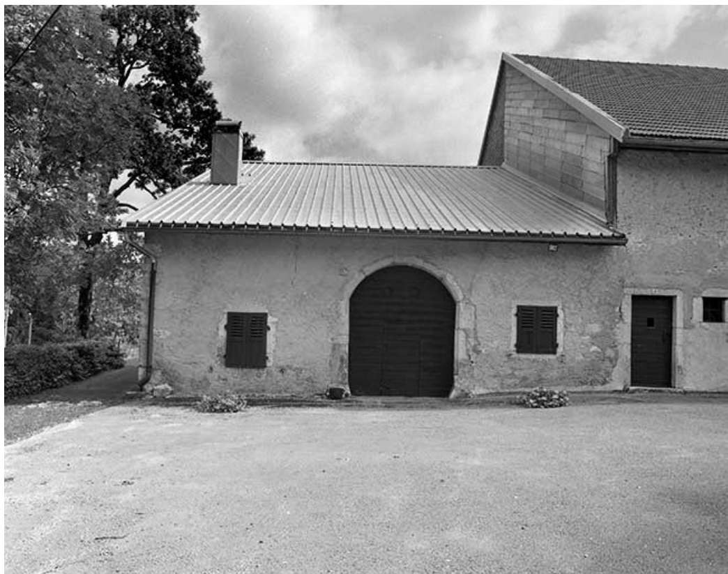
Façade postérieure de la ferme de droite.
