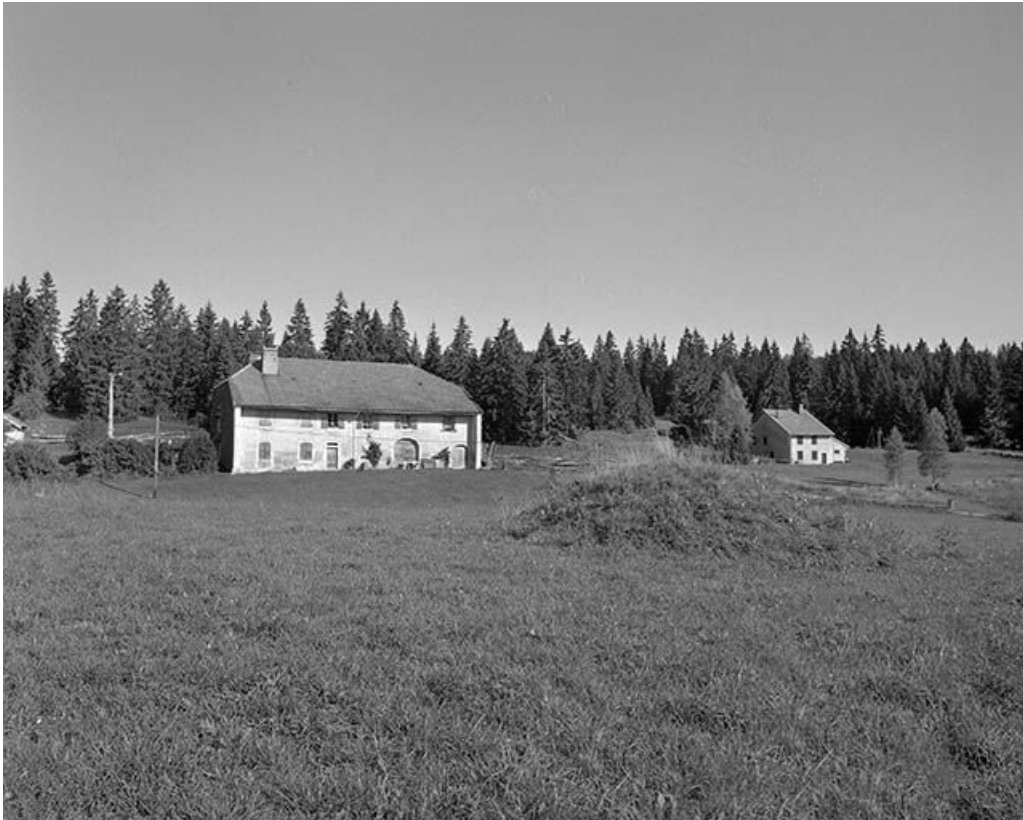
Façade antérieure, vue éloignée.
