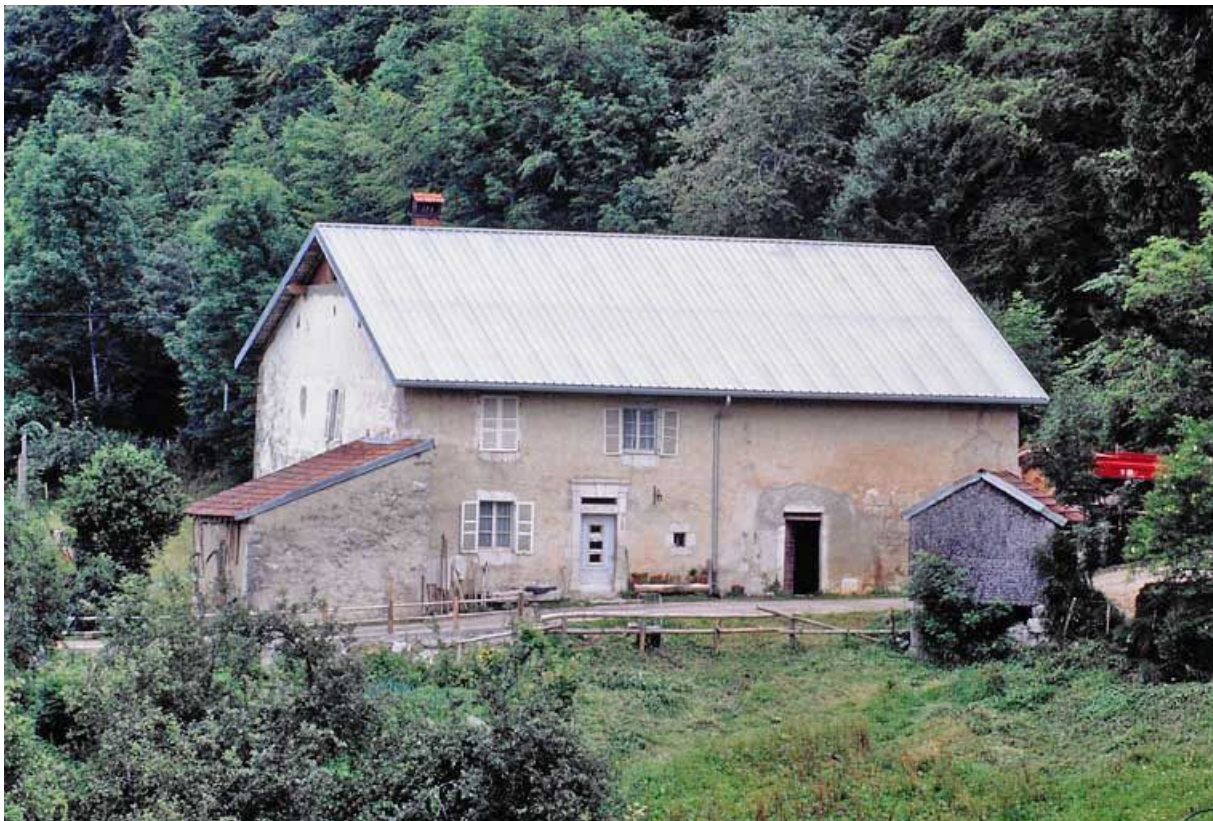
Vue éloignée de la façade antérieure.
