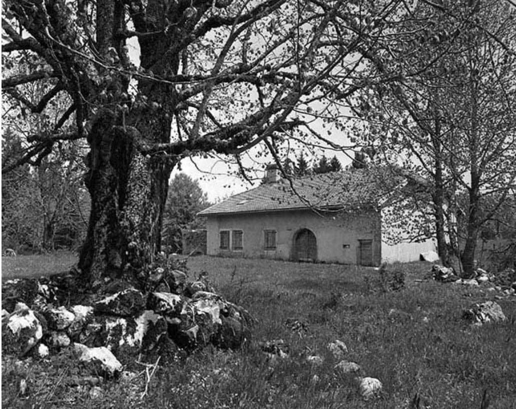
Vue éloignée de la façade postérieure.
