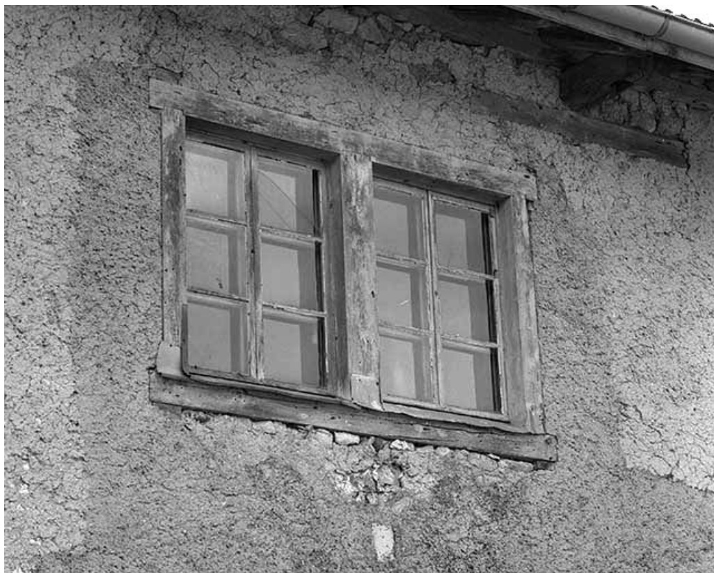
Fenêtre double sur la façade postérieure.
