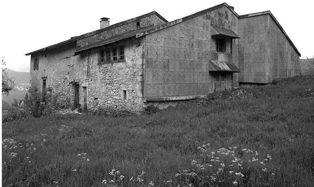
Face gauche et façade postérieure.
