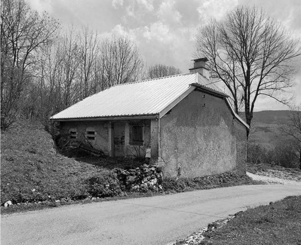
Façade antérieure et face droite.
