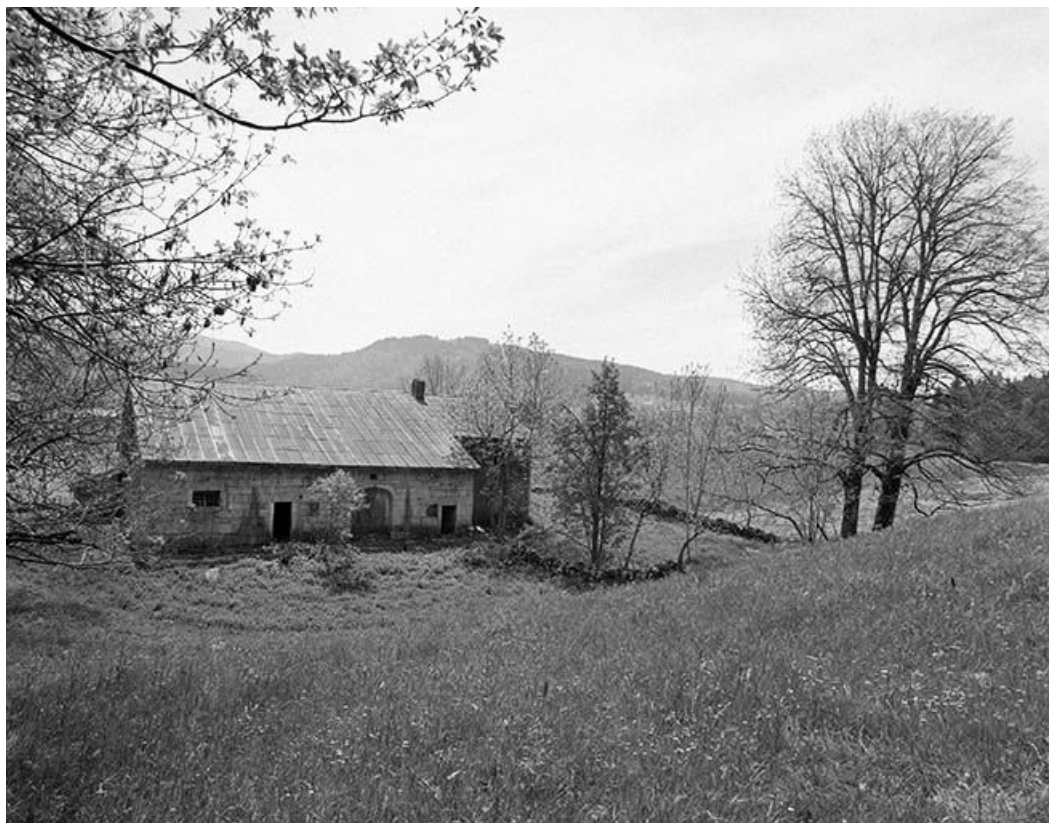
Vue éloignée de la façade postérieure.
