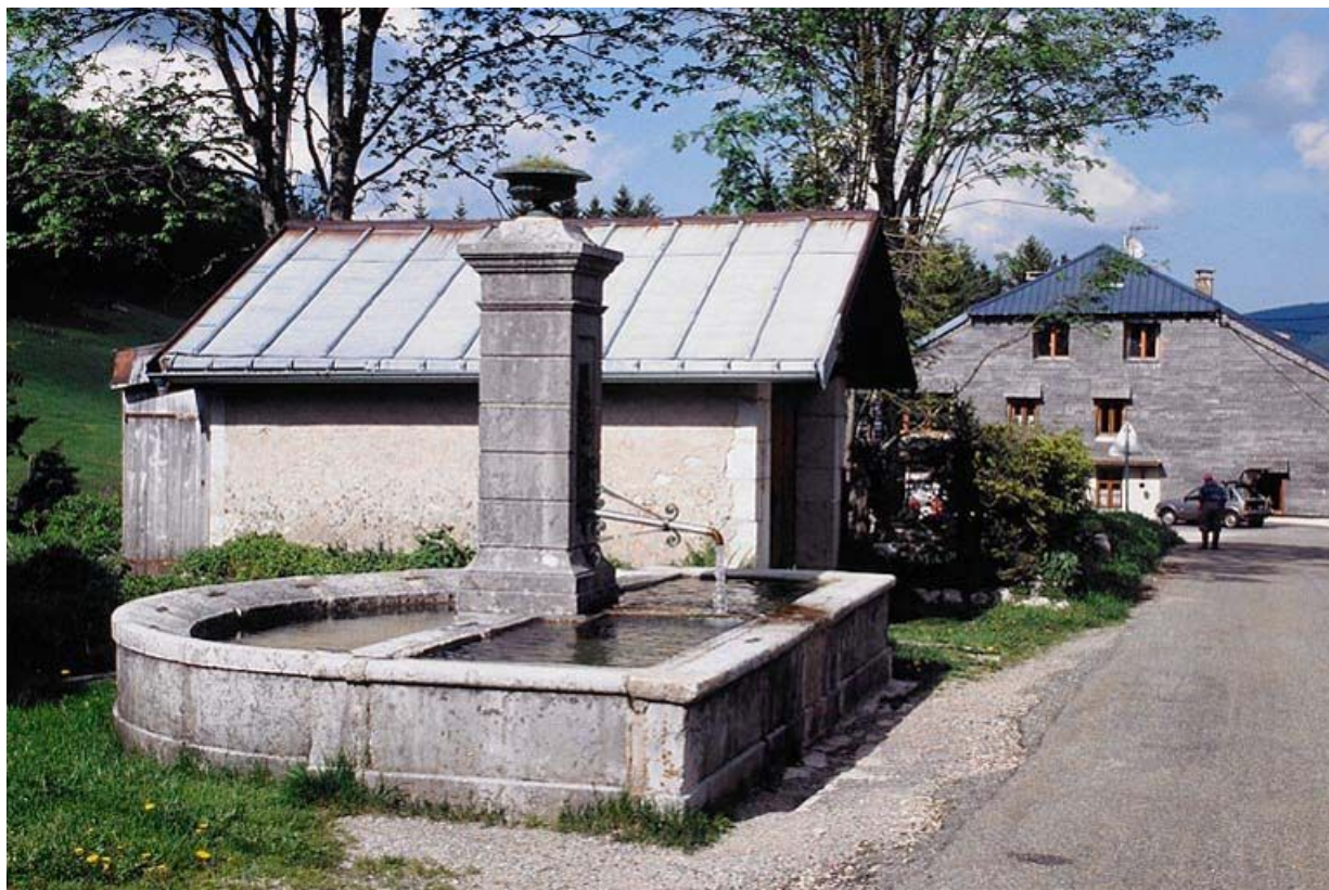
Vue générale de la fontaine.
