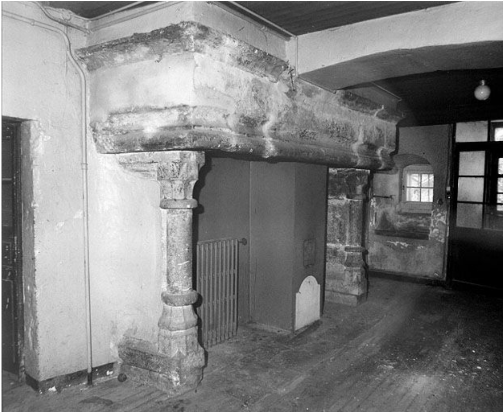
Vue intérieure, cheminée.
