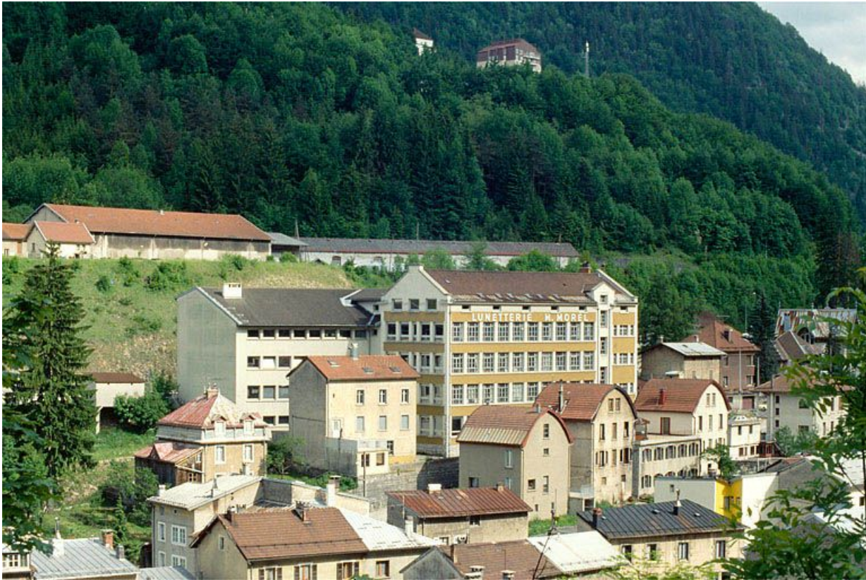
Vue d'ensemble de la façade postérieure.
