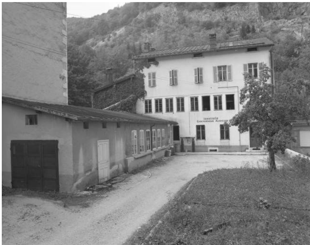
Cour et façade antérieure.
