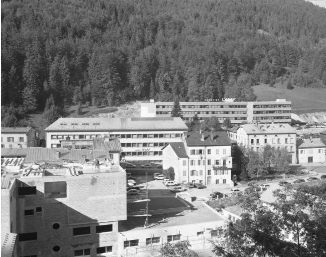
Site récent : vue d'ensemble.
