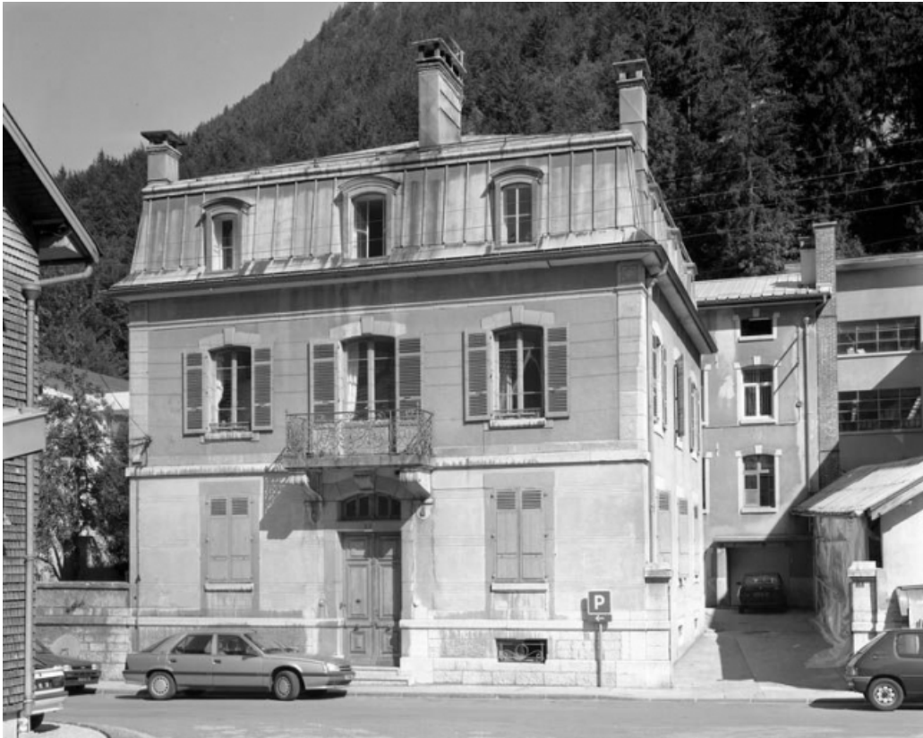
Site ancien : façade antérieure du logement.
