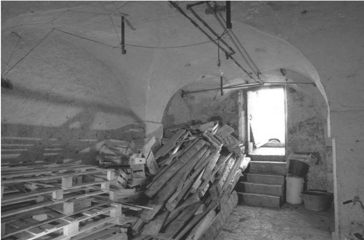
Pièce voûtée, en sous-sol.
