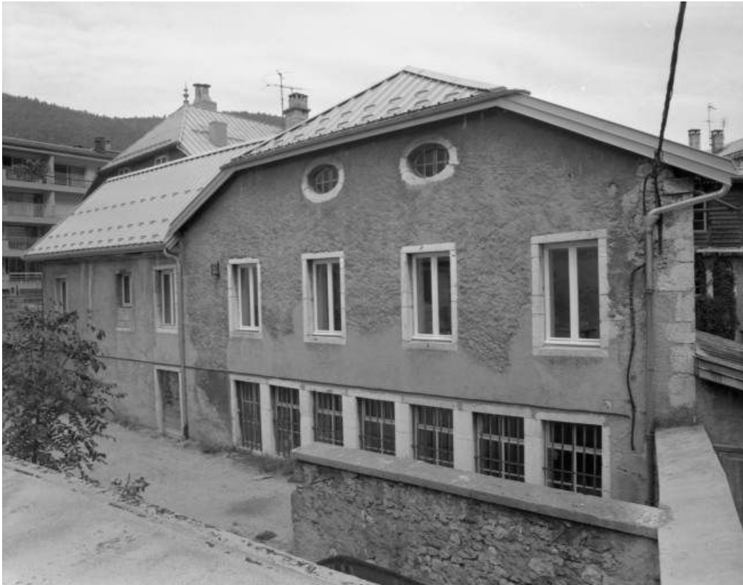
Façade latérale droite de l'usine.
