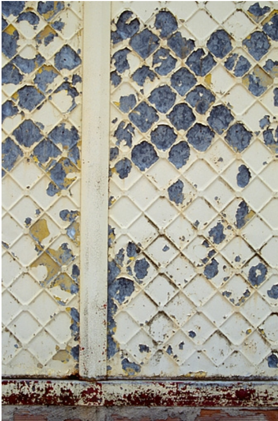
Détail d'un panneau métallique (façade latérale gauche).
