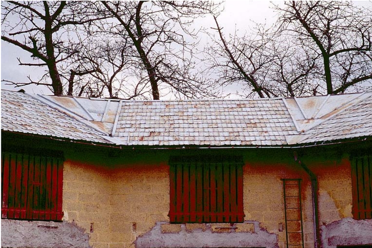
Remise d'automobile et bûcher (F) : toiture couverte de tuiles métalliques. 39, Saint-Amour rue des Enversys
