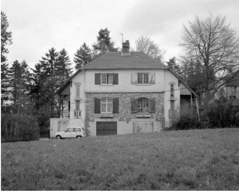
Maison (B) : façade antérieure.
