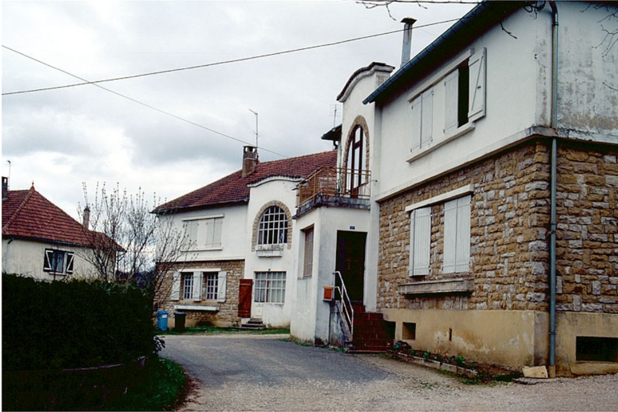
Maisons (G, H) : vue d'ensemble.
