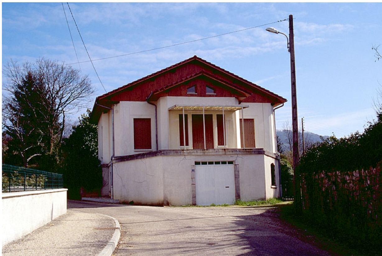
Maison métallique rue de Peroset : façade antérieure.
