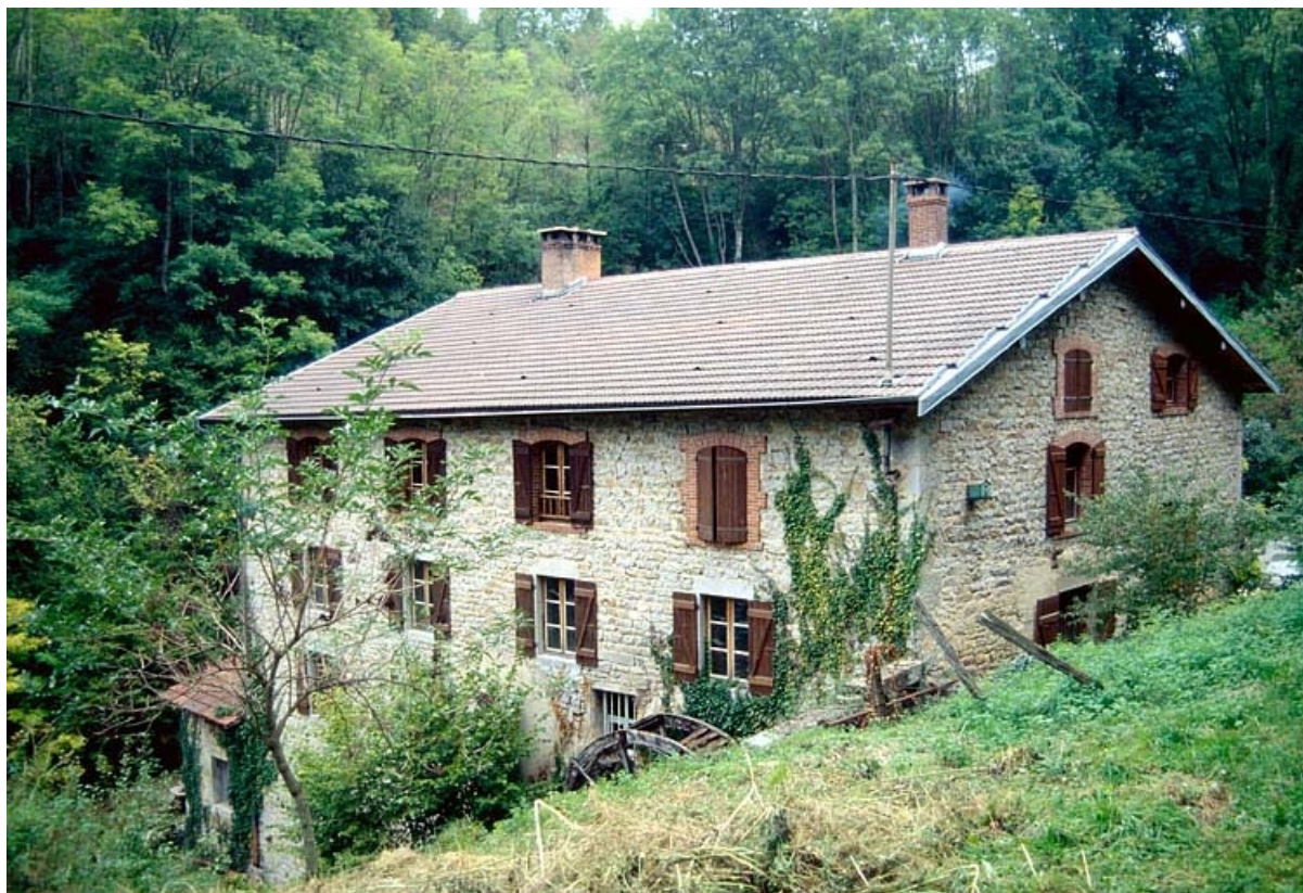
Façades postérieure et latérale gauche.
