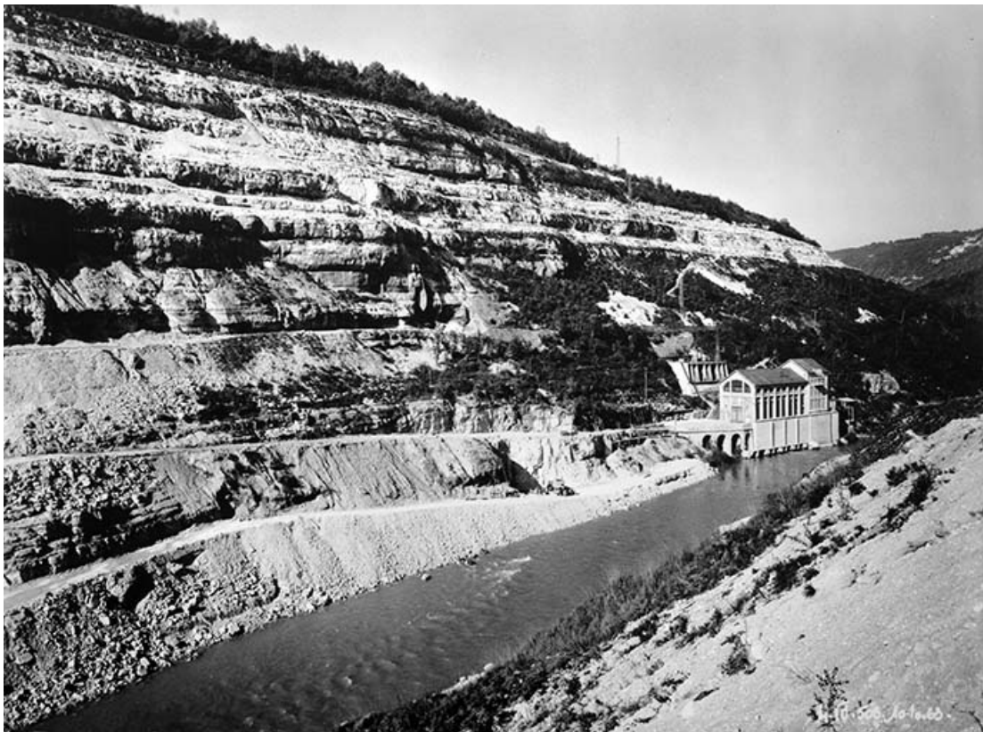
Amont de l'appui rive droite. Tête amont de la dérivation provisoire [et centrale de la chartreuse de Vacluse]. 39, Cernon, lieudit : Barrage de Vouglans
