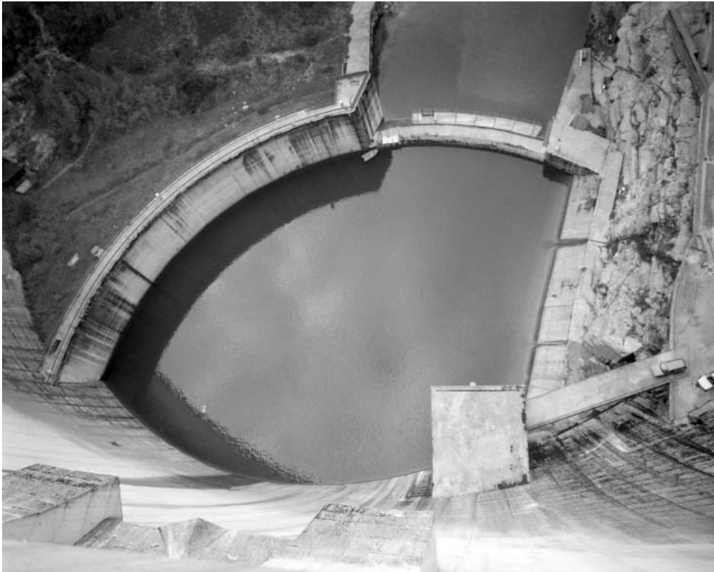
Vue plongeante sur le bassin d'amortissement.
