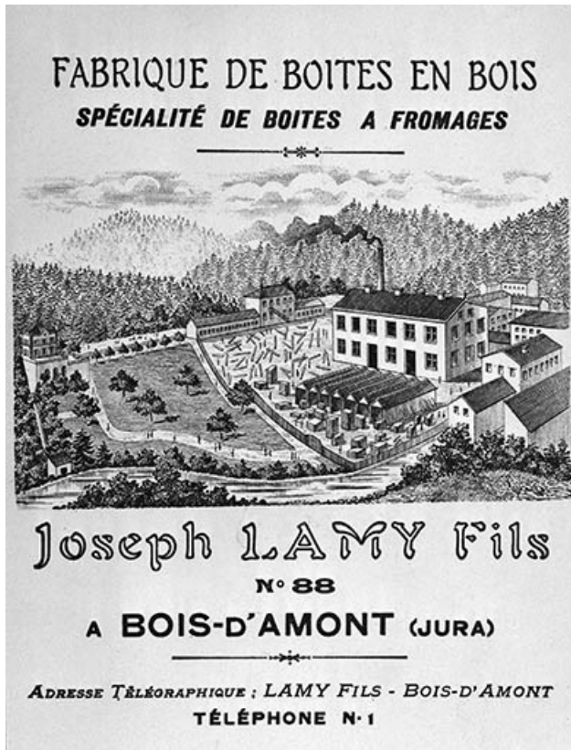
Vue cavalière de l'usine.
