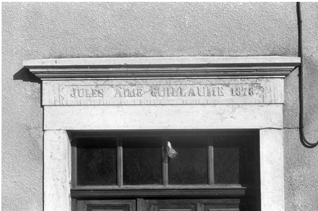
Linteau de la porte d'entrée.
