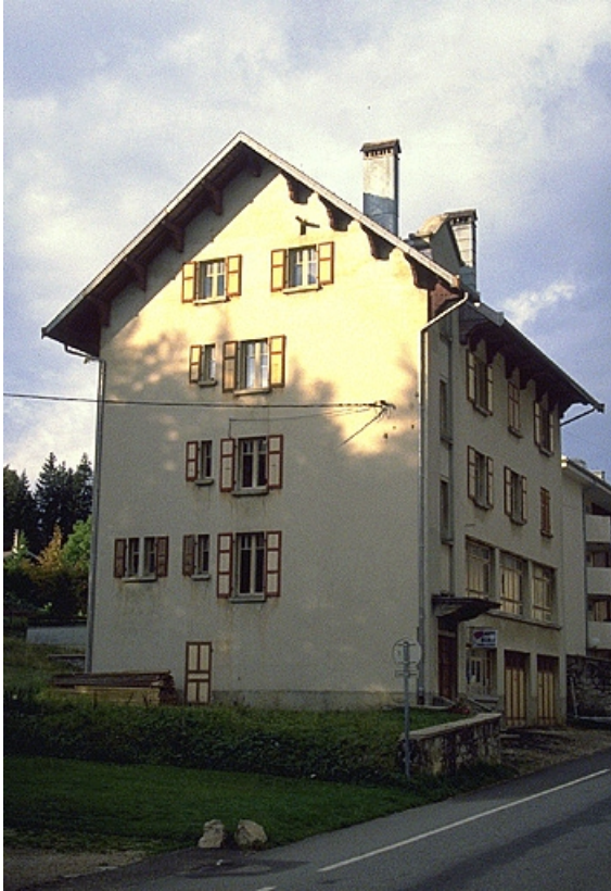
Façades antérieure et latérale gauche.
