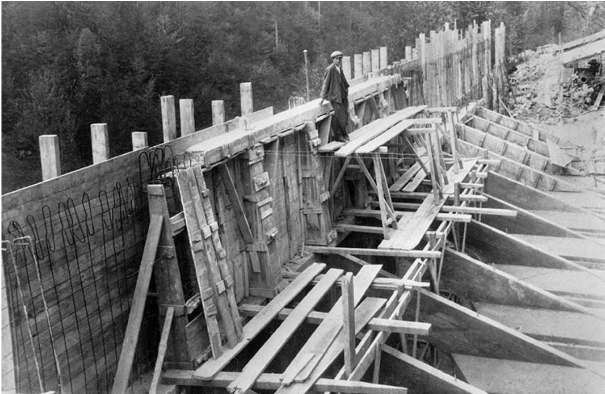
Construction du bassin de retenue.
