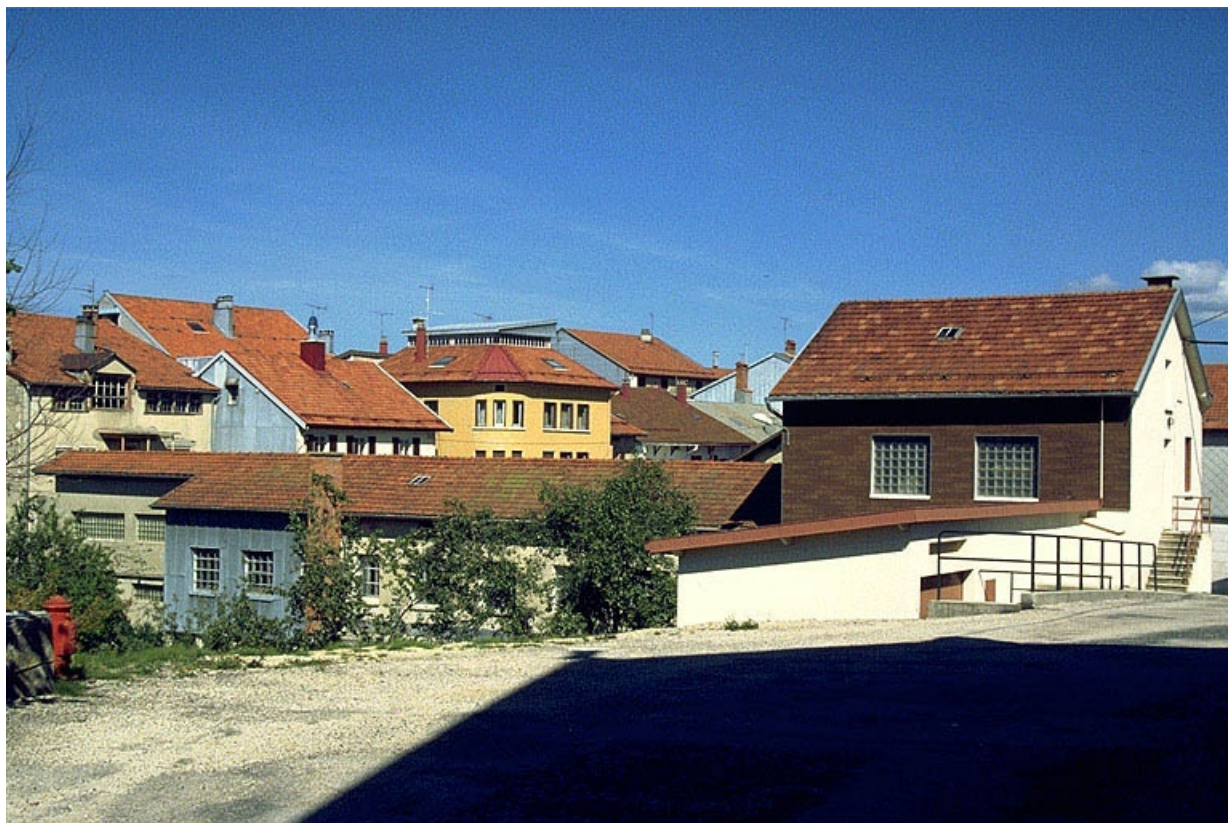
Façade postérieure de l'usine.
