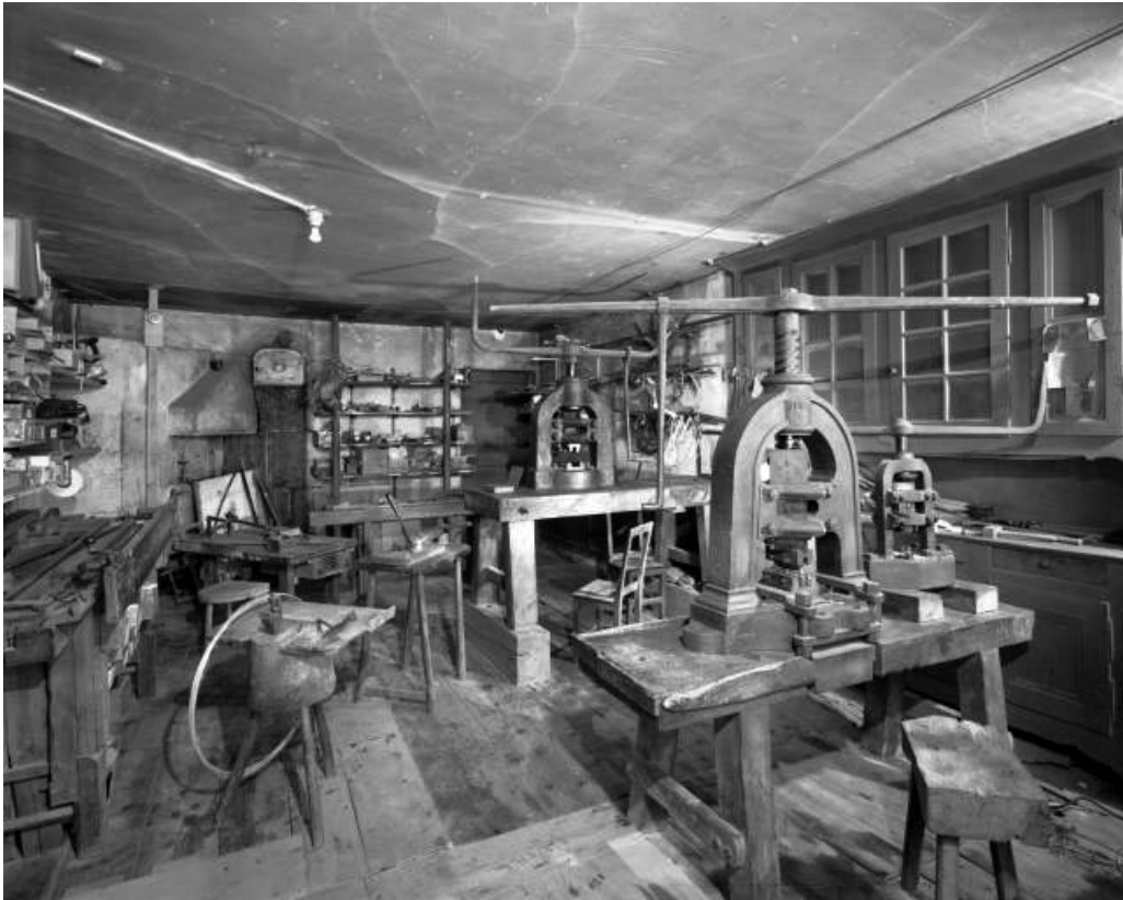
Intérieur de l'atelier de fabrication.
