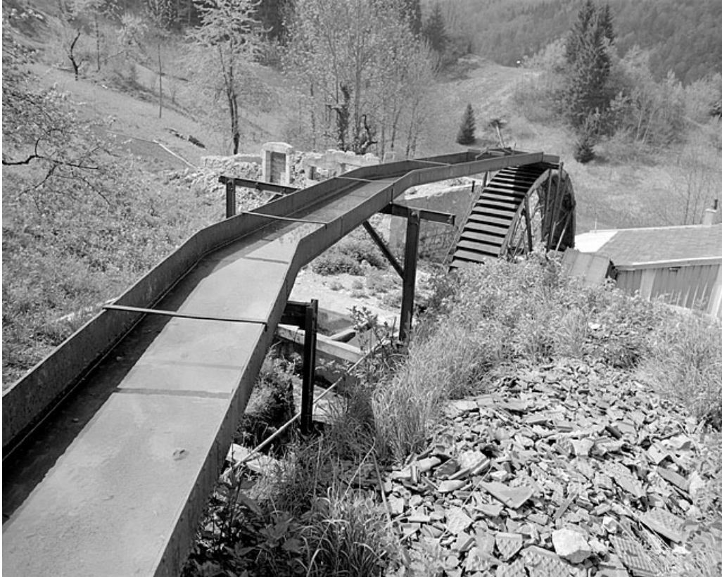
Canal d'amenée métallique et roue hydraulique.
