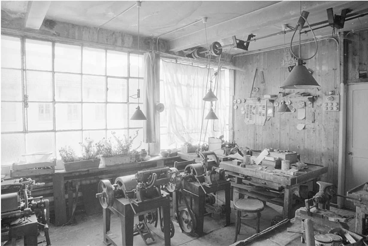
Intérieur de l'atelier de fabrication.
