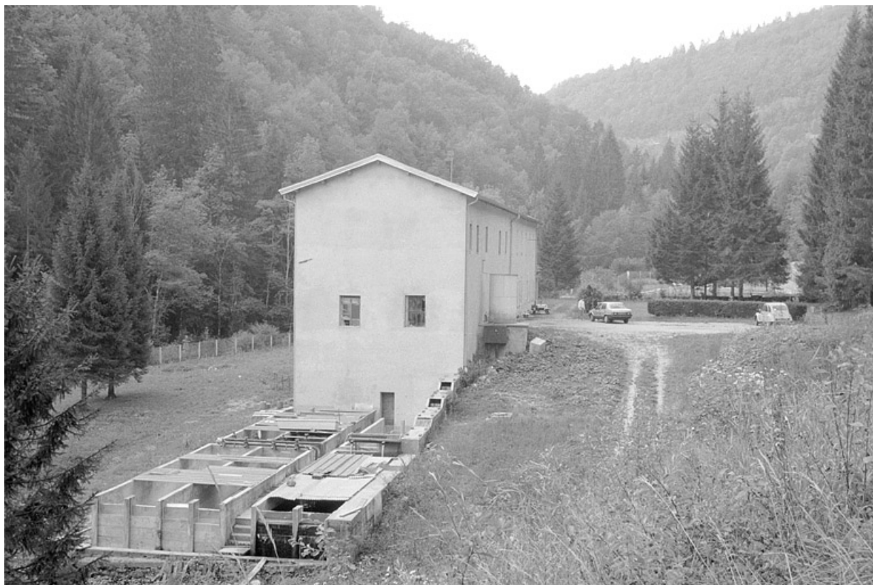
Bâtiment depuis le nord.
