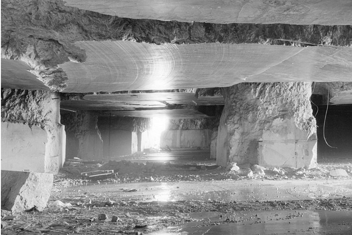
Carrière souterraine de Chassal : galerie latérale. 39, Molinges
