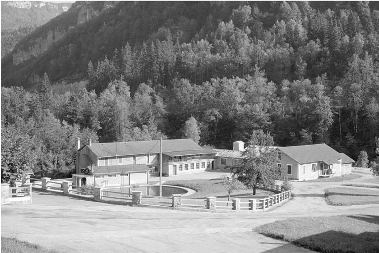
Ancienne usine, vue depuis le nord-ouest.
