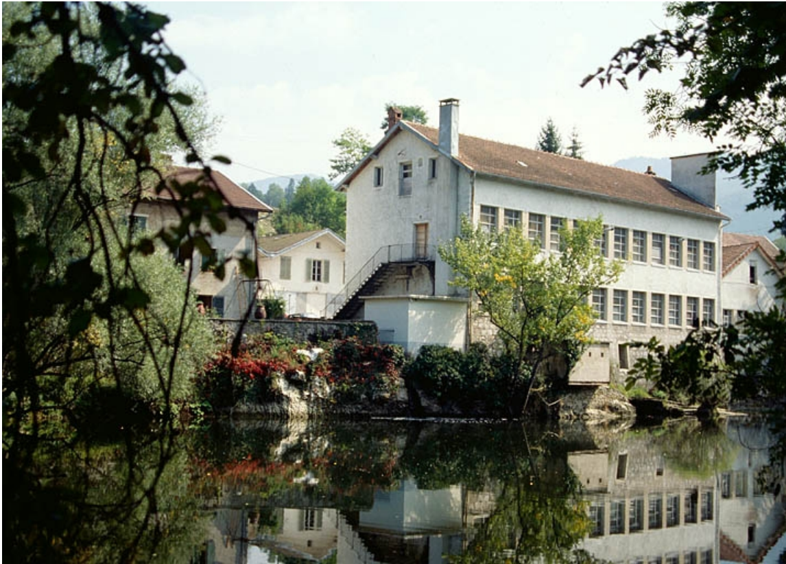
Atelier de fabrication, depuis le nord-ouest (aval).
