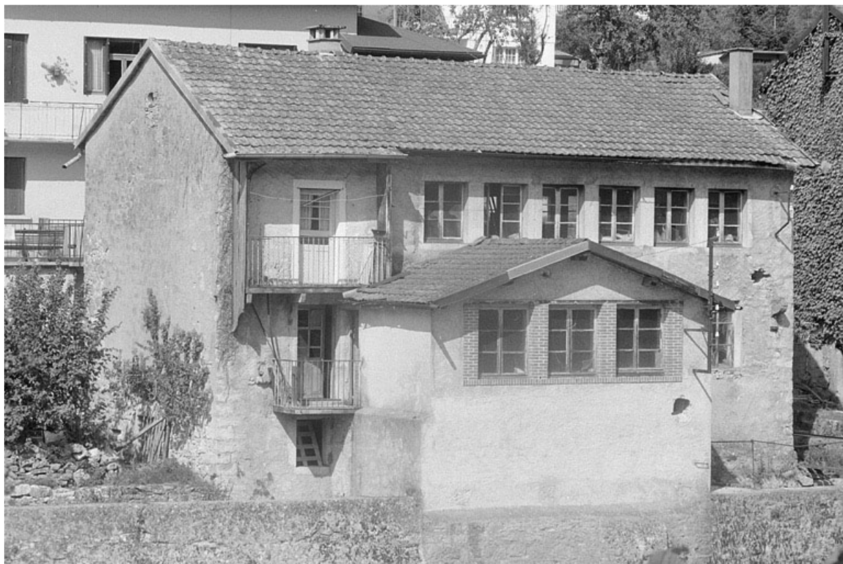
Atelier de fabrication et salle des machines.
