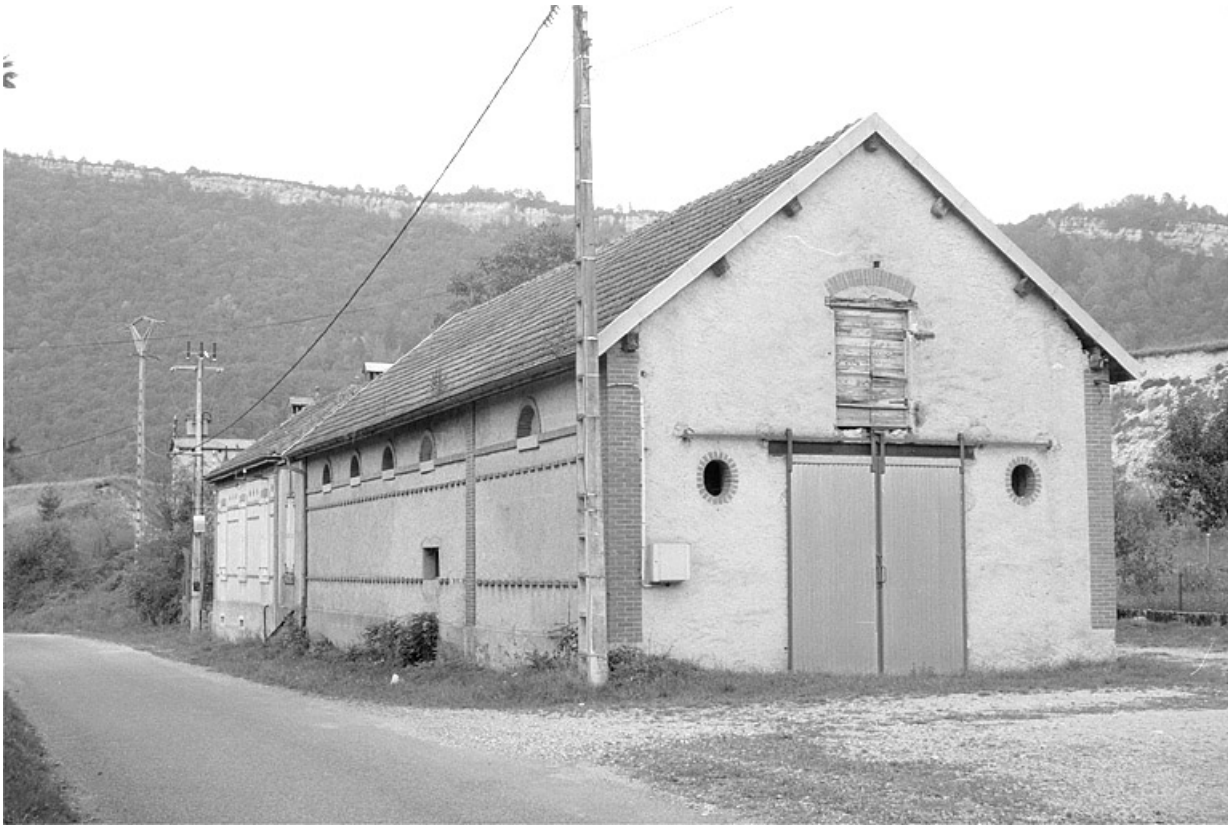
Les dépendances agricoles vues depuis la route.
