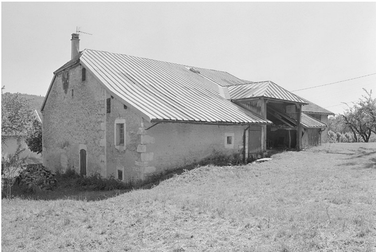
Façade postérieure et face droite.
