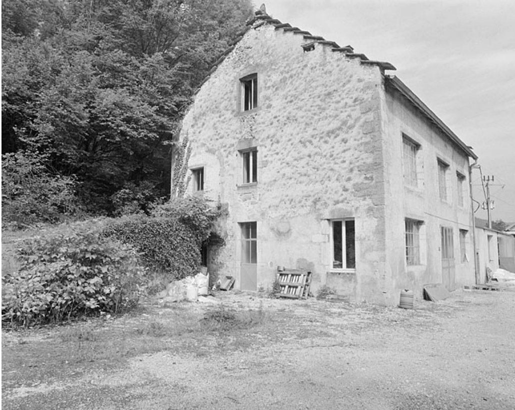
Façade antérieure et face gauche du moulin.
