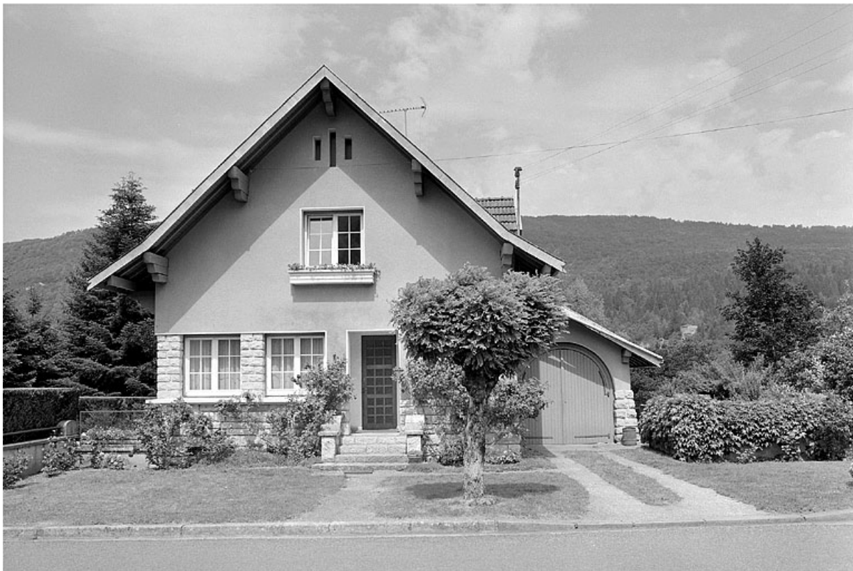
Maison reconstruite après guerre.
