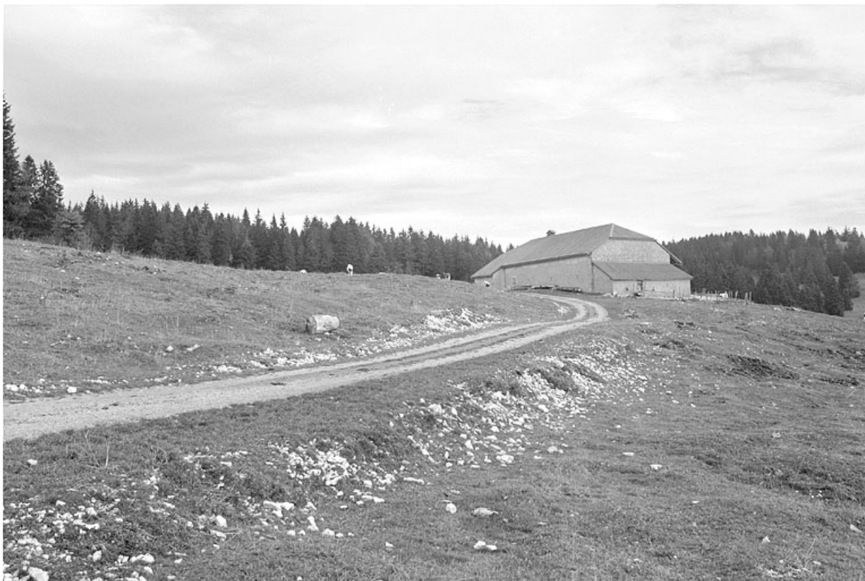
Vue générale depuis le chemin d'accès.
