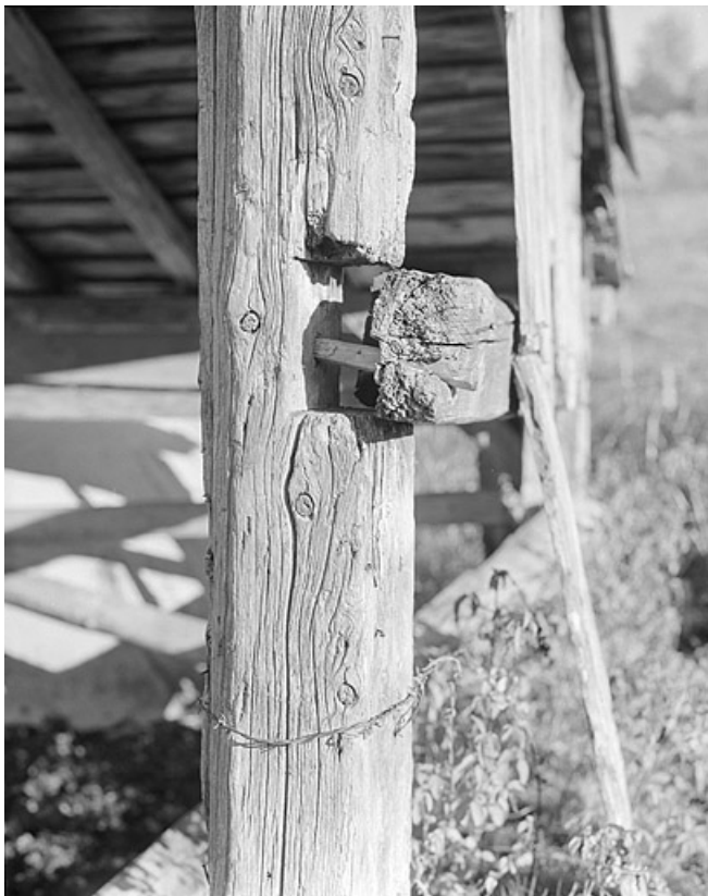
Assemblage à mi-bois poteaux-panne par une cheville.
