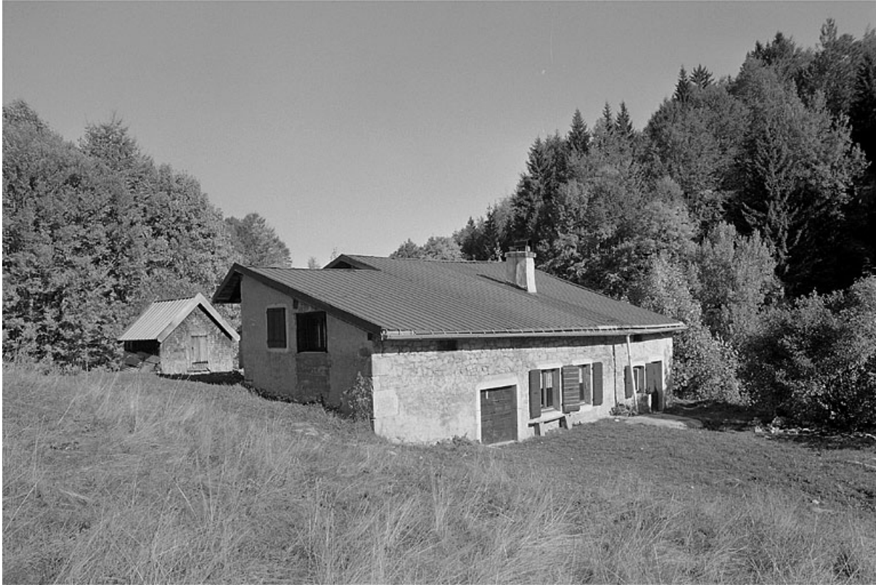
Façade antérieure et face sud-ouest.
