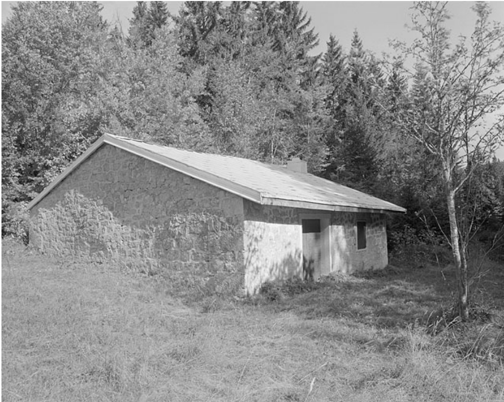
Face sud-ouest et façade antérieure.
