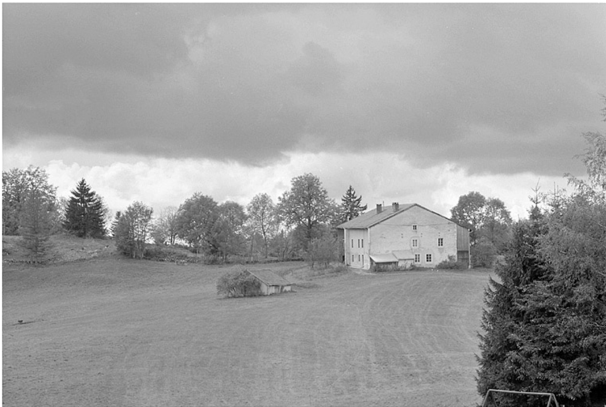
Vue générale depuis l'est.
