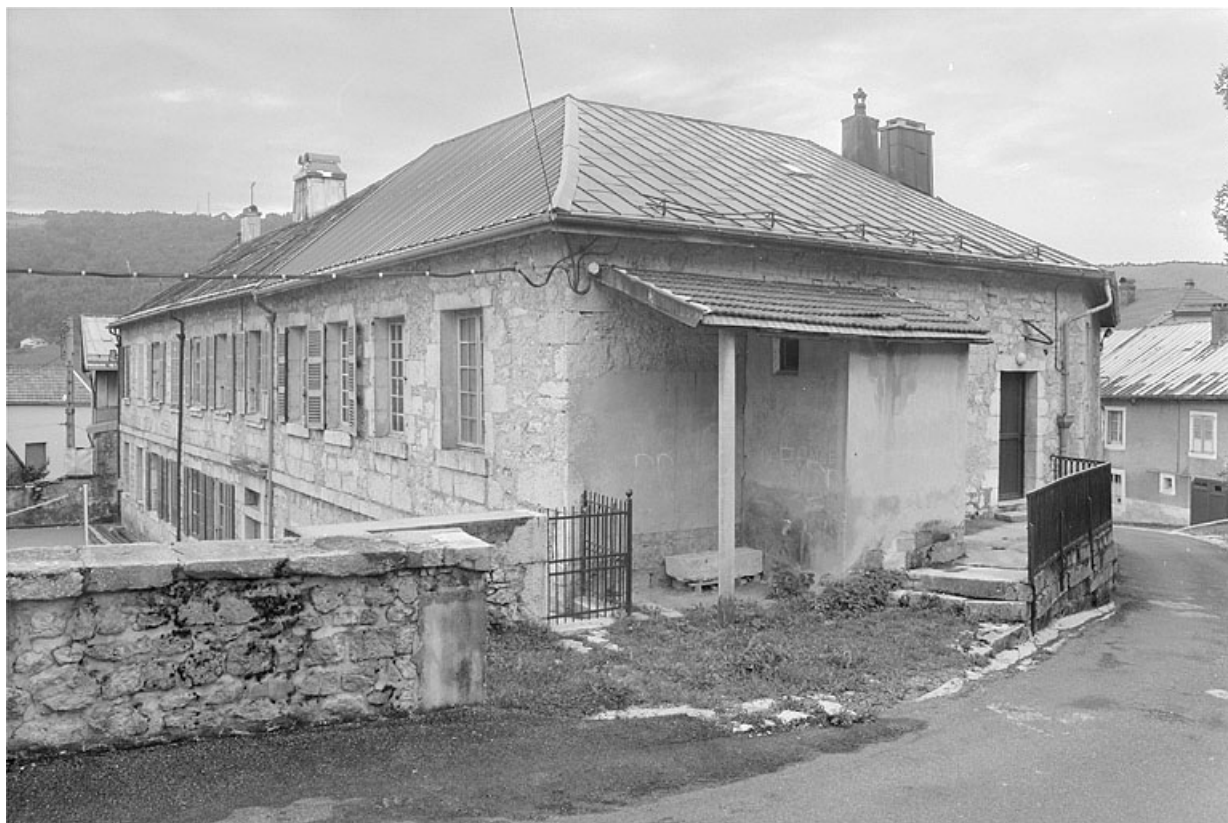
Façade postérieure et face ouest.
